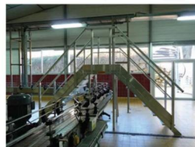
Avec Lisses Sous lisses et Plinthes. Entièrement boulonnés, les garde-corps peuvent être démontés pour le transport, réassemblés et adaptés en longueur sur les sites d'installation.
